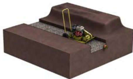
Verdicht het aangebrachte splitmateriaal Compactage du concassé amené
