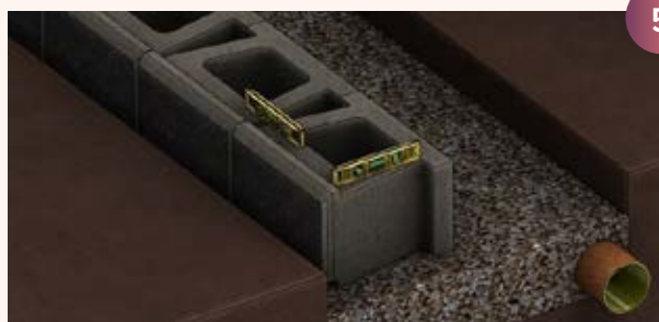
Controleer of de blokken waterpas staan Contrôle de la mise à niveau des blocs
